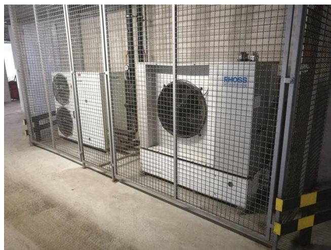
Slika 6.20: Hladilna agregata RHOSS, TIP CWA/E in Icaeb1002201308 Vir: lastni vir.
