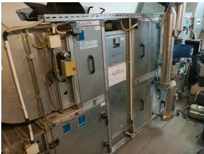
Slika 6.21: Klimatska naprava IMP KNMD 12/6 D25 Vir: lastni vir.
