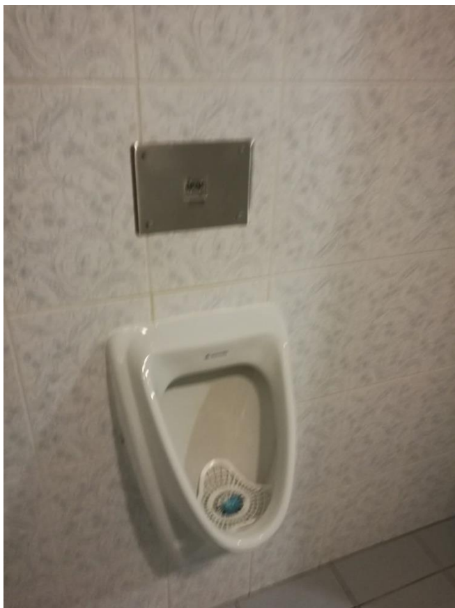
Slika 5.13: Pisoarji s senzorjem in EMV ventilom Vir: lastni vir.
