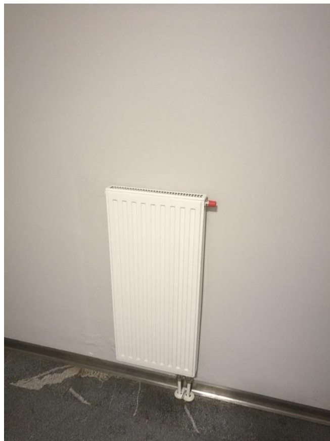
Slika 5.8: Ploščati radiator brez termostatskega ventila
