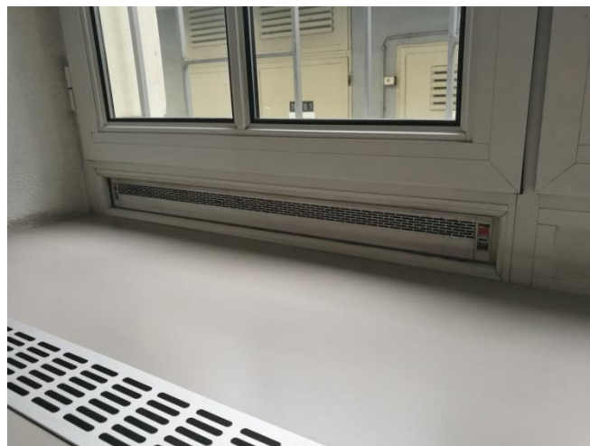
Slika 6.26: Posnetek prezračevalnih rešetk na okenskih okvirjih starejšega dela stavbe
