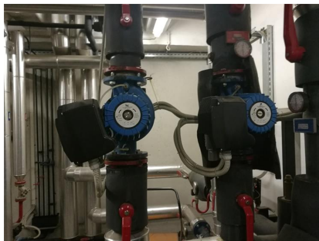
Slika 5.4: Posnetek obtočnih črpalk – II. FAZA Vir: lastni vir.
