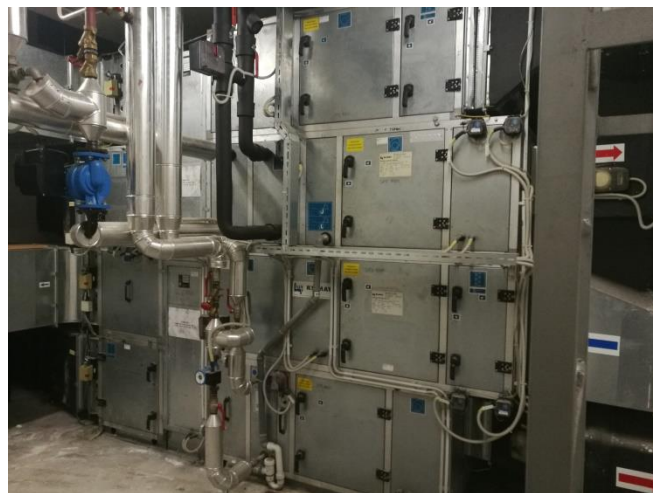
Slika 6.22: Klimatska naprava IMP KNMD 9/9 D25 Vir: lastni vir.
