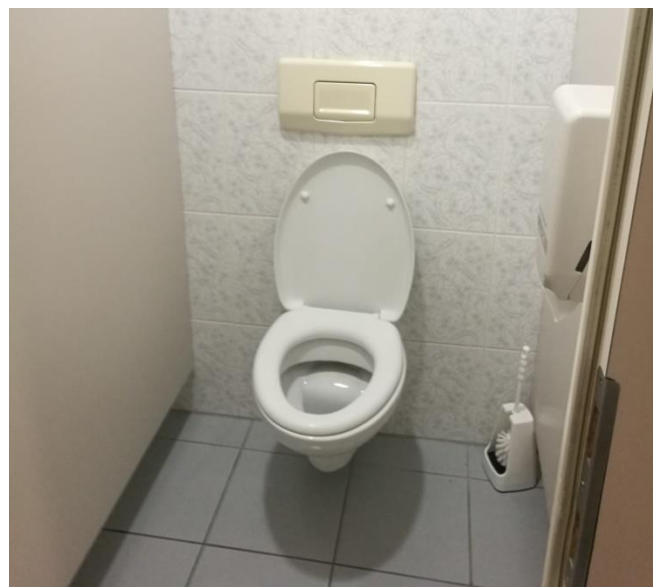
Slika 5.16: WC z podometnim kotličkom brez varčevalne tipke Vir: lastni vir.
