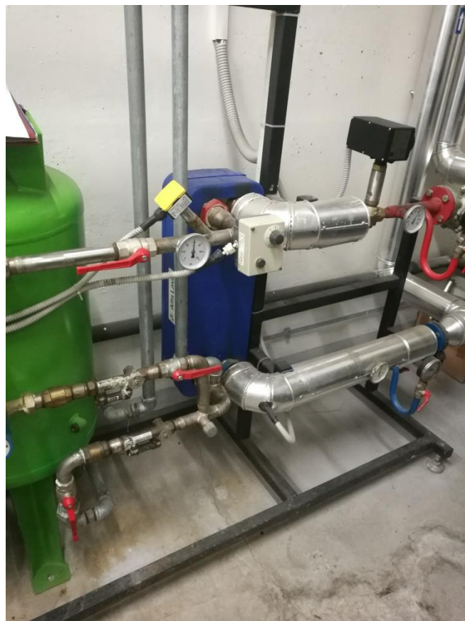
Slika 5.10: Toplotni izmenjevalec za TSV Vir: lastni vir.
