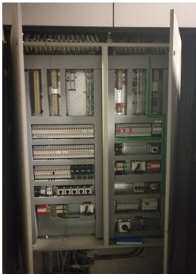
Slika 5.20: Posnetek etažnega razdelilca Vir: lastni vir.
