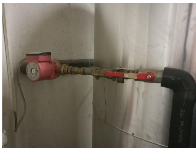
Slika 5.12: Cirkulacijska črpalka za TSV – II. FAZA Vir: lastni vir.
