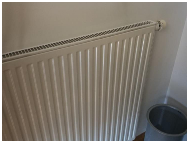
Slika 5.6: Ploščati radiator s termostatsko glavo
