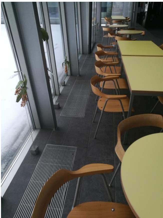
Slika 5.7: Talni konvektorji v povezovalnem hodniku med starejšim in novejšim delom stavbe
