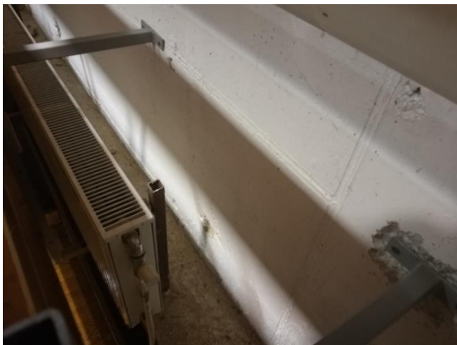
Slika 5.5: Radiator brez termostatskega ventila, ki je montiran za leseno oblogo – Predavalnica 3 – II. FAZA
