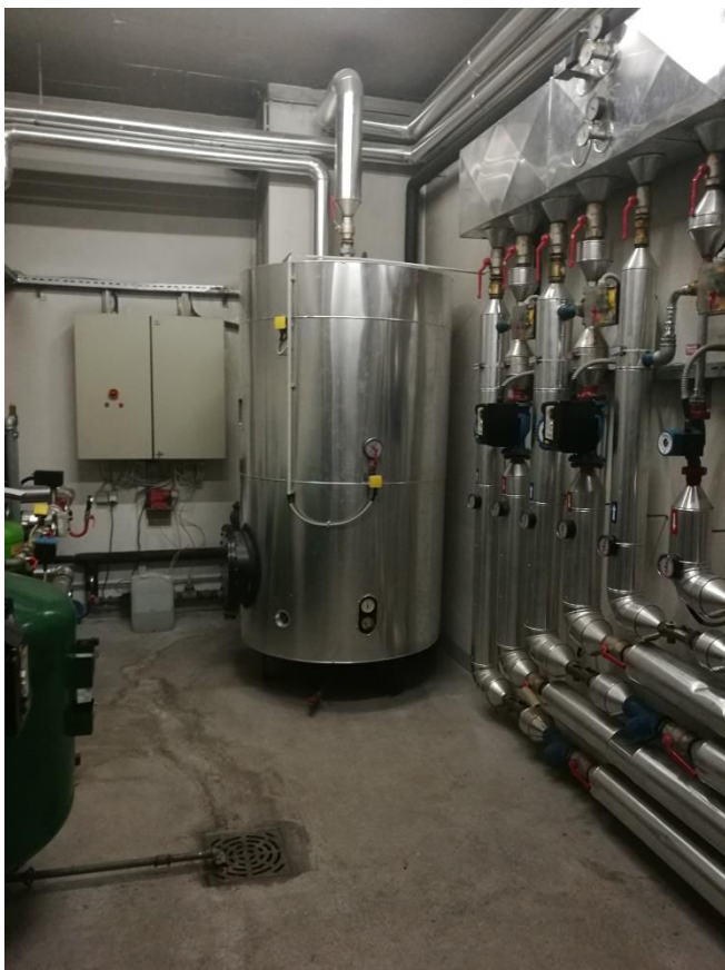
Slika 5.9: Hranilnik TSV, kapacitete 2000 litrov – I. FAZA Vir: lastni vir.
