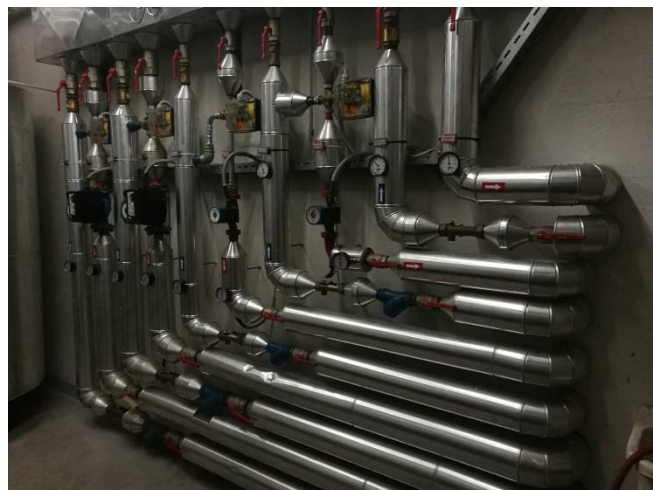
Slika 5.2: Posnetek razdelilnika ogrevanja v toplotni postaji – I. FAZA Vir: lastni vir.
