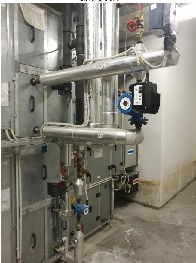
Slika 6.21: Klimatska naprava IMP KNMD 12/6 D25 Vir: lastni vir.
