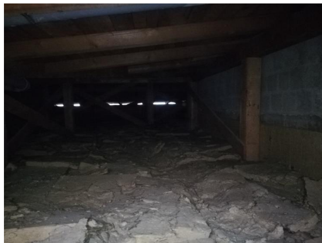
Slika 6.4: Posnetek toplotne izolacije na tleh neogrevanega podstrešja – I.FAZA Vir: lastni vir.
