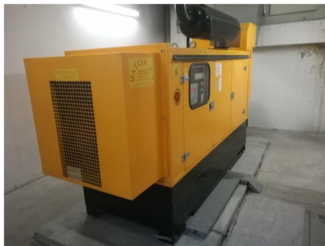
Slika 5.18: Posnetek dizel-elektro agregata
