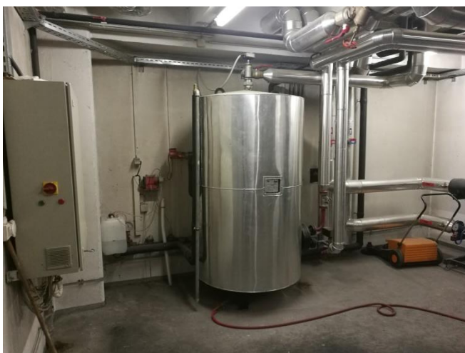
Slika 5.11: Hranilnik TSV, kapacitete 1300 litrov Vir: lastni vir.
