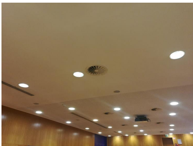
Slika 6.19: Dovodne in odvodne rešetke v predavalnici 3 Vir: lastni vir.
